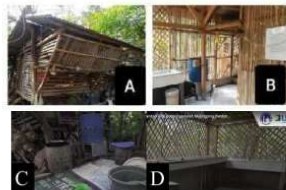
Gambar 2. Kondisi Fasilitas Produksi RPA Cari Berkah Sebelum (A) dan Sesudah Kegiatan Abdimas (B). Lokasi Proses Produksi Sebelum Abdimas Berada di Ruang Terbuka (C) Dan Kondisi Proses Produksi Setelah Renovasi Fasilitas Produksi (D)
