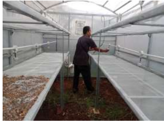
Gambar 10. Pemasangan Rangkaian Lampu pada Ruang
