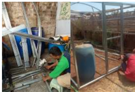
Gambar 5. Pemotongan Stainless Steel 304 dan Pemasangan Kerangka Ruang Pengering
