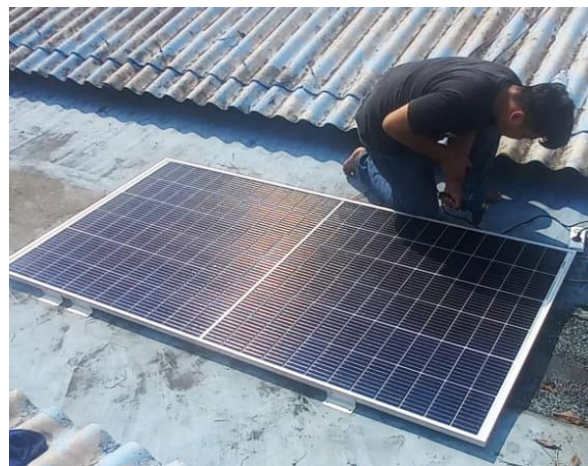
Gambar 4. Pemasangan Panel Surya
