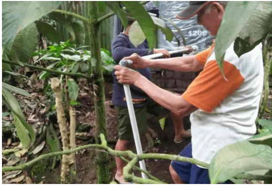
Gambar 8. Pemasangan Pipa Utama Untuk Mengambil Aliran Air dari Tandon
