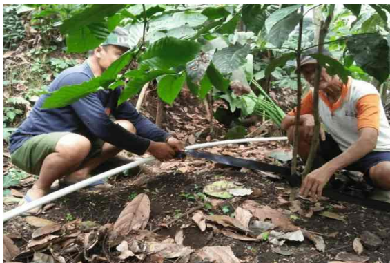
Gambar 10. Instalasi Pipa Pembagi ke Pipa Lateral
