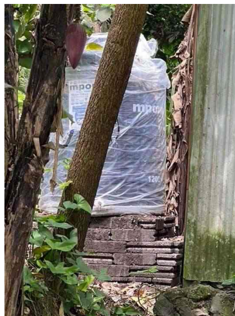
Gambar 7. Pemasangan Tandon Air ( Tower )
