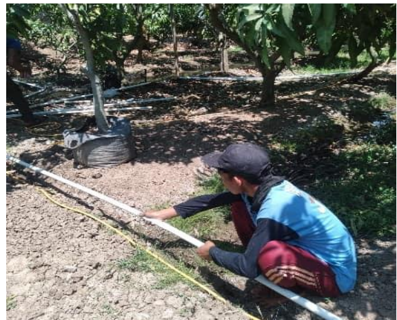
Gambar 4. Pemasangan Sprinkle System
