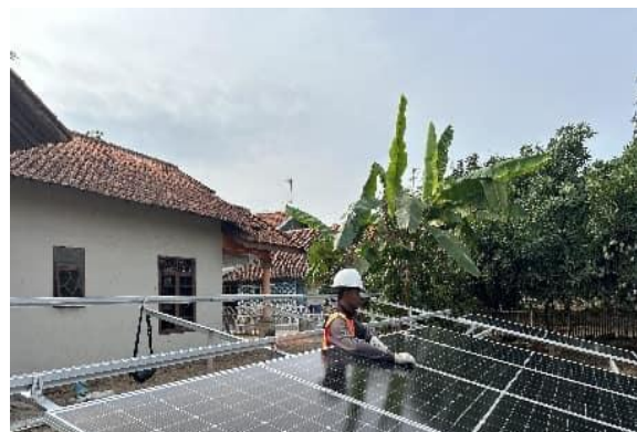
Gambar 5. Pemasangan PLTS
