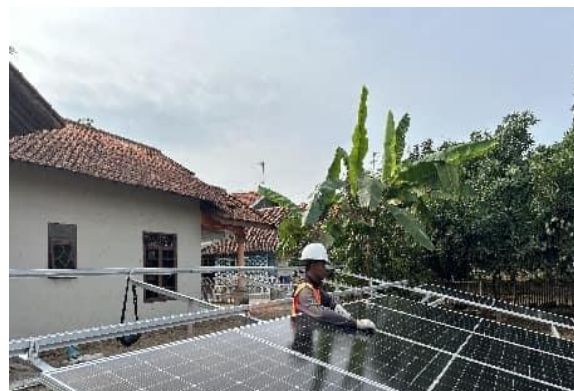
Gambar 5. Pemasangan PLTS
