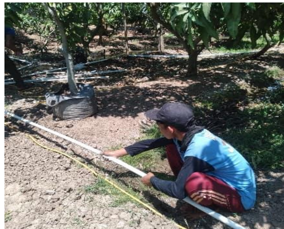
Gambar 4. Pemasangan Sprinkle System
