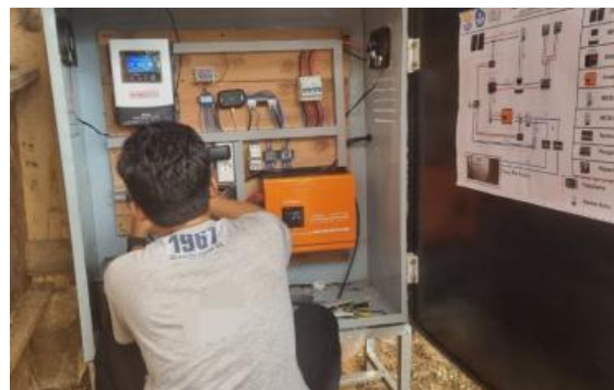
Gambar 6. Perakitan Panel Surya Yang Terintegrasi Dengan IoT
