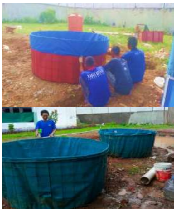
Gambar 6. pengecekan dan pemasangan kolam dan saluran drainase air
